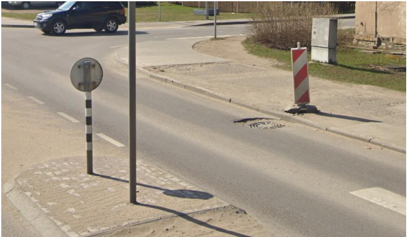
1 pav. Važiuojamosios dalies būklė ties vandens surinkimo šulinėliais
